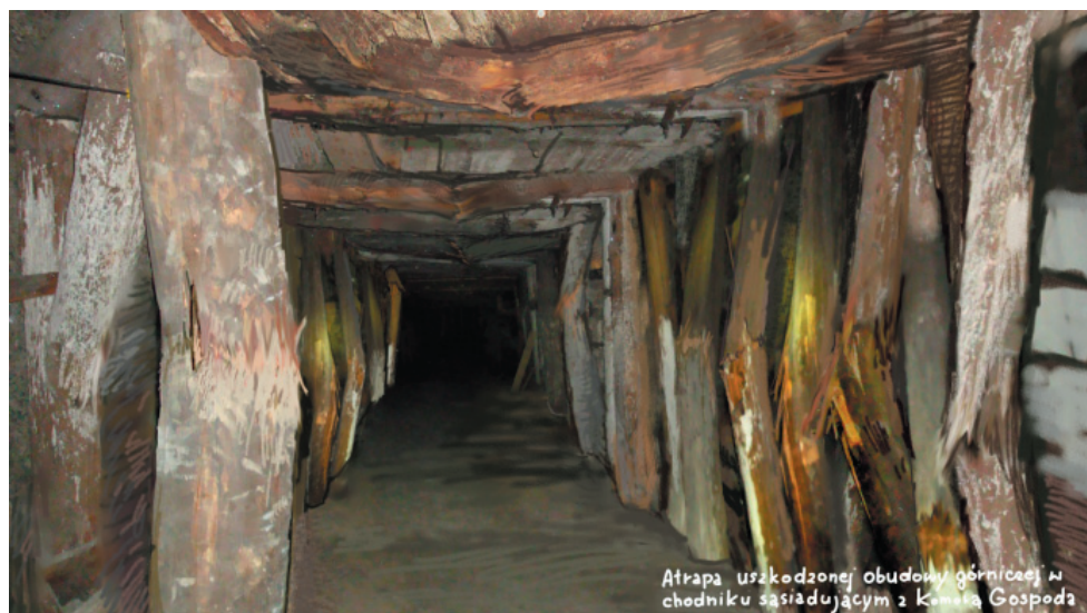
Rys. 3. Imitacja zniszczonej obudowy chodnikowej w komorze Gospoda (Grupa Eskadra, 2011)
